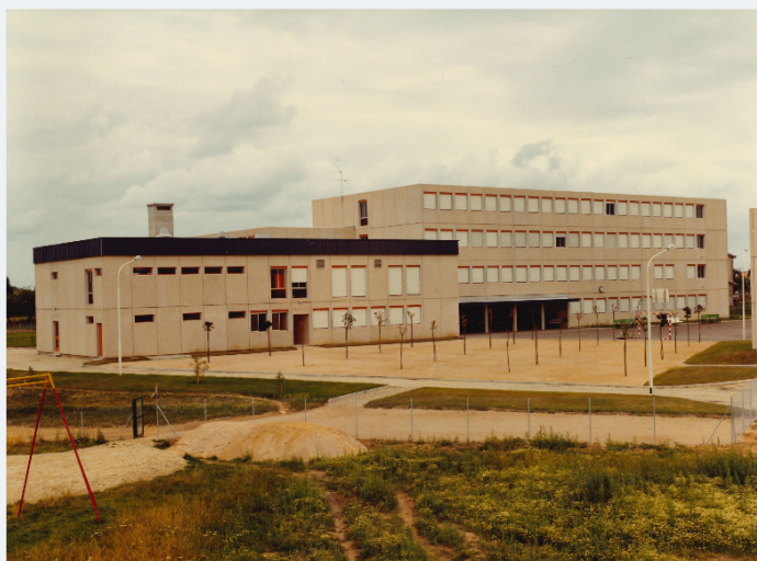
Le collège Les Côtes avant sa reconstruction.
